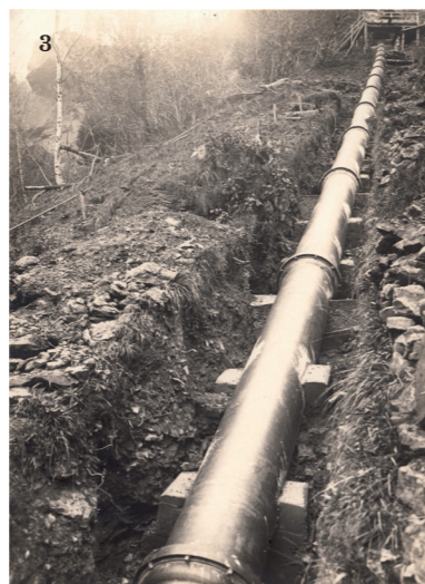
3. Bau der Druckleitung um 1925/26. Diese besteht aus Graugussrohren von 5 Metern Länge mit einem Nenndurchmesser von 600 mm. Zwischen den Muffen ist jedes Rohr auf drei schalenförmigen Sockeln gelagert.
