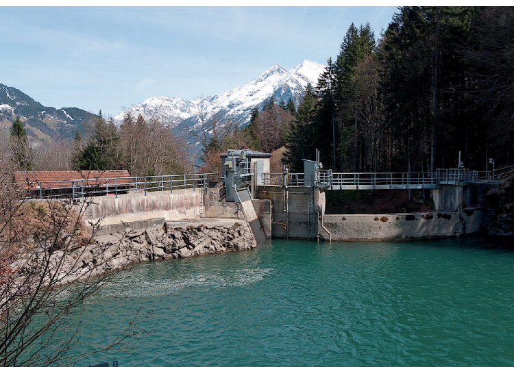
Über das Staubecken Zwirgi wird das Wasser für die beiden Kraftwerke Schattenhalb 2 und 3 entnommen. Stiftung Kraft & Wasser
